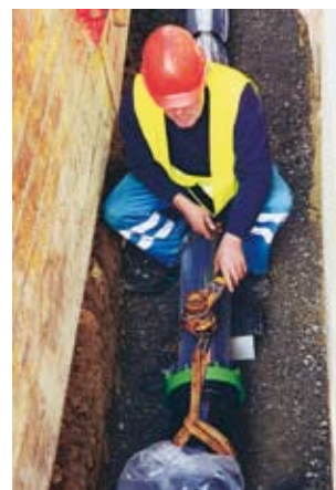
In der Schweiz sind heute rund 50'000 km Wasserleitungen verlegt.
